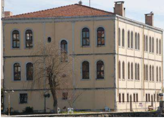
Resim 5: Dr. Rıza Nur Kütüphanesi binası kuzeybatı cephesi
