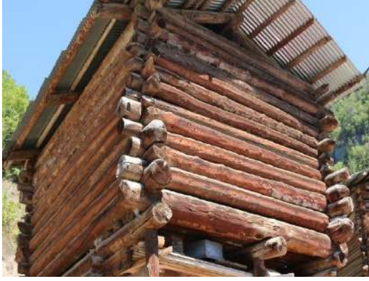
Fotoğraf 1: Karaboğaz ve kurtboğazı geçme yöntemlerinden birer görünüm.
