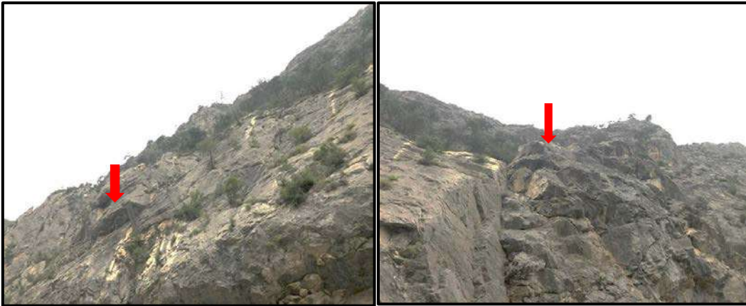
 ekil 12: Kızılırmak Kanyonu'nda Kaya D  mesini   nemeye Y nelik Yapılmı  Olan Tel   rg .
