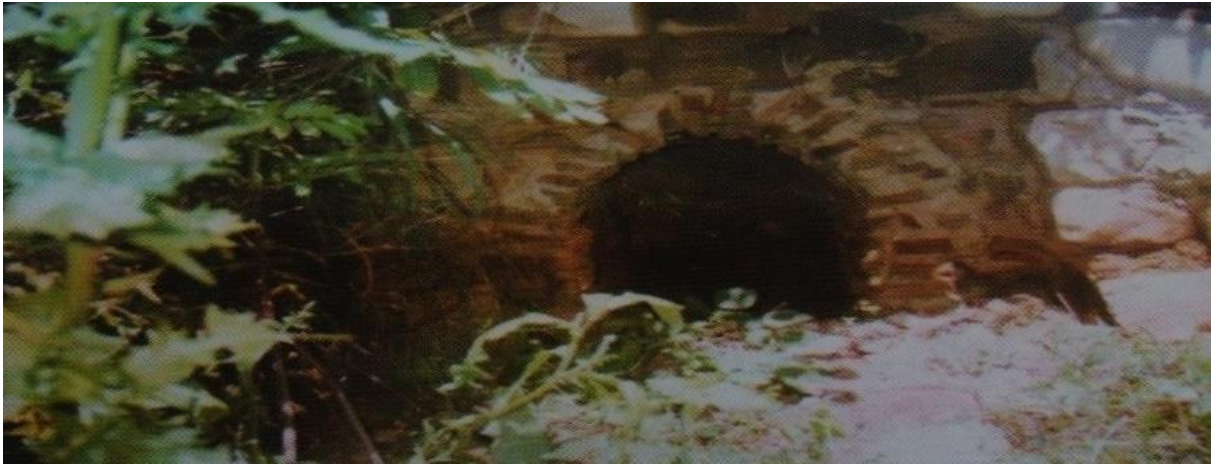
Şekil 19: Lala Ky Frenk Mahallesindeki Roma Hamamı Kalıntısı. (Roma Hamamı Kalıntısı, 2013: 61)
