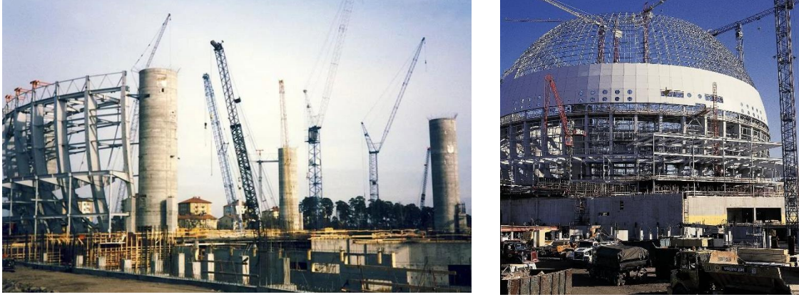
Şekil 11. Stockholm Globe Arena yapım aşamaları ve strüktürü [14]
