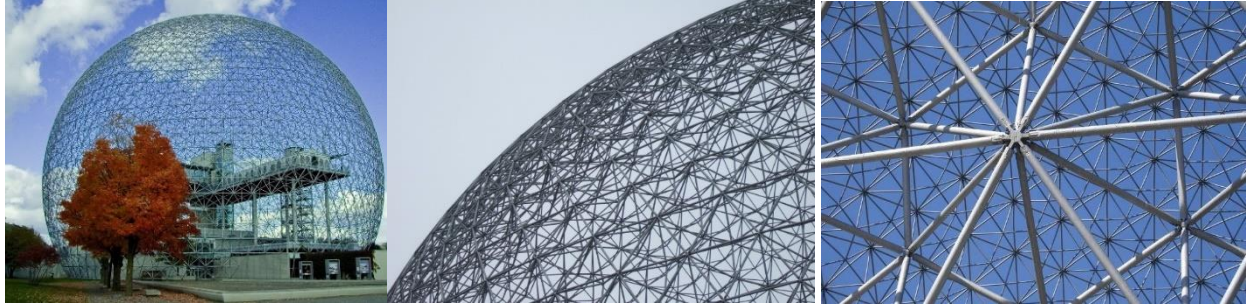
Şekil 7-8-9. Biosphère Görünüm, Biosphère İki tabakalı uzay kafesi sistemi ve Birleşim detayı [11]
